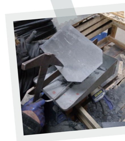
Chaque ardoise est taillée à la main par l'entreprise Guillaneuf couverture puis fixée grâce à des clous en cuivre crantés (plus robustes car ne rouillent pas)
