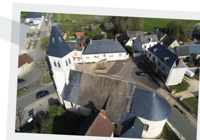
État du toit entre les deux phases de travaux
